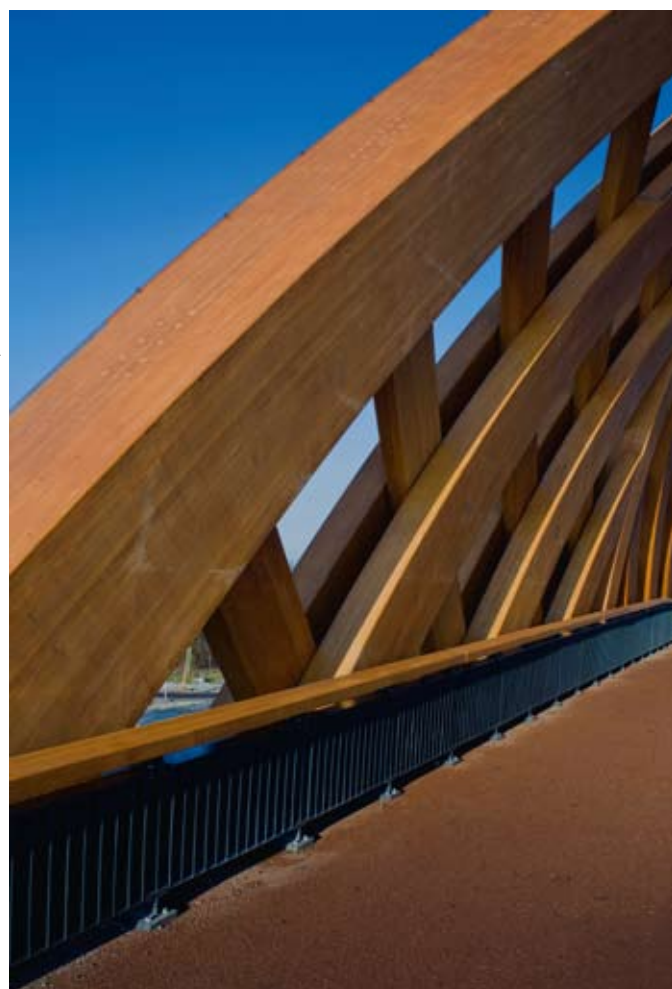
Detail van de vakwerkconstructie.
