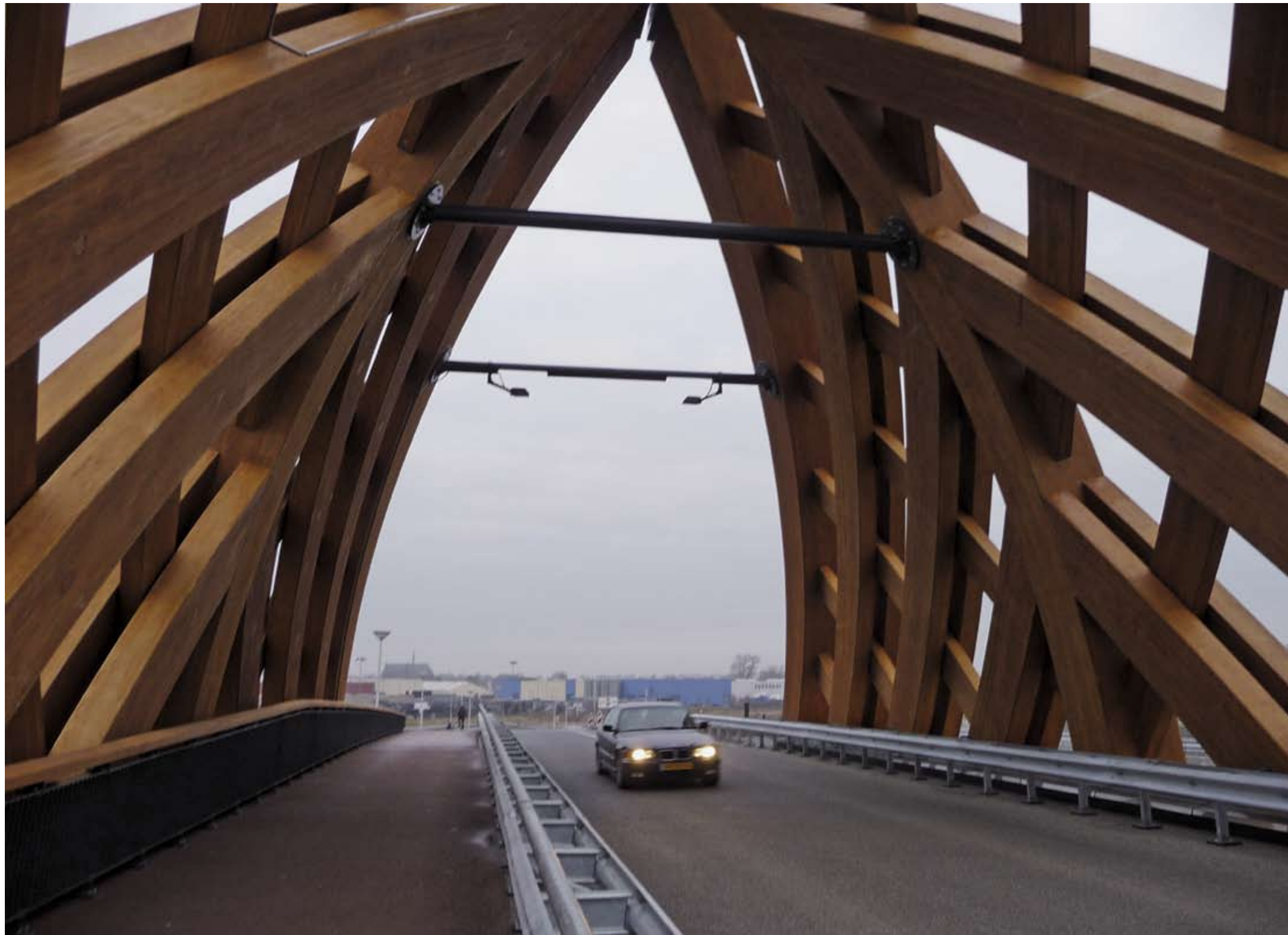
De spanten zijn op pneumatische mallen in vorm geperst.
